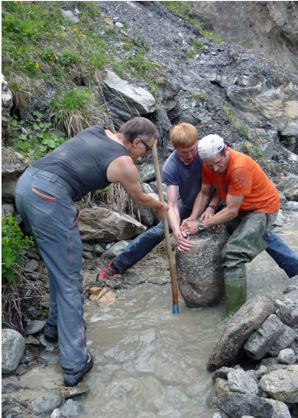
Gemeinwerk an der Suone Niwärch VS: Räumen der Fassung. Urheberrechte: SL-FP)
